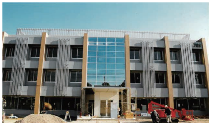
写真 1 ほぼ建物外観が完成した本部建物
